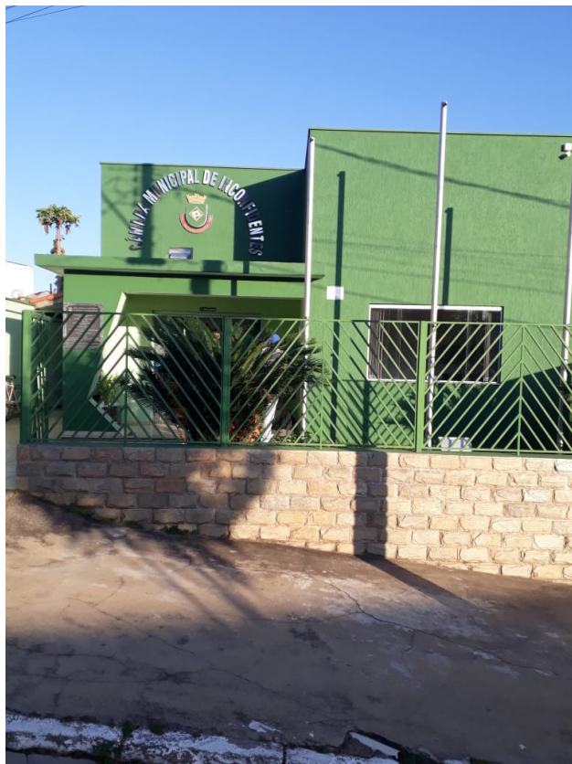
Figura 1 – Fachada da Câmara antes de iniciar a obra
