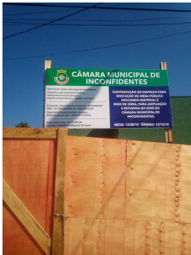
Figura 2. SERVIÇOS PRELIMINARES GERAIS
