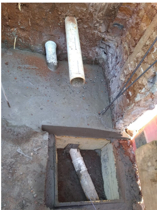
Figuras 12 a 20 – ESTRUTURA
