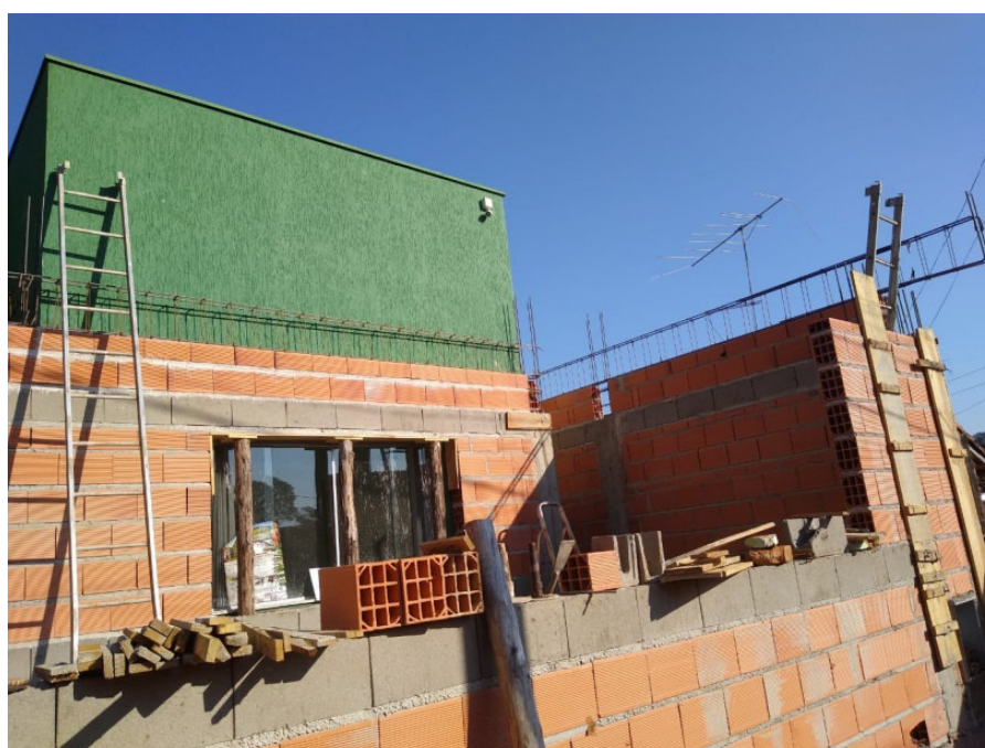
Figuras 3 a 7 - ESTRUTURA e ALVENARIA
