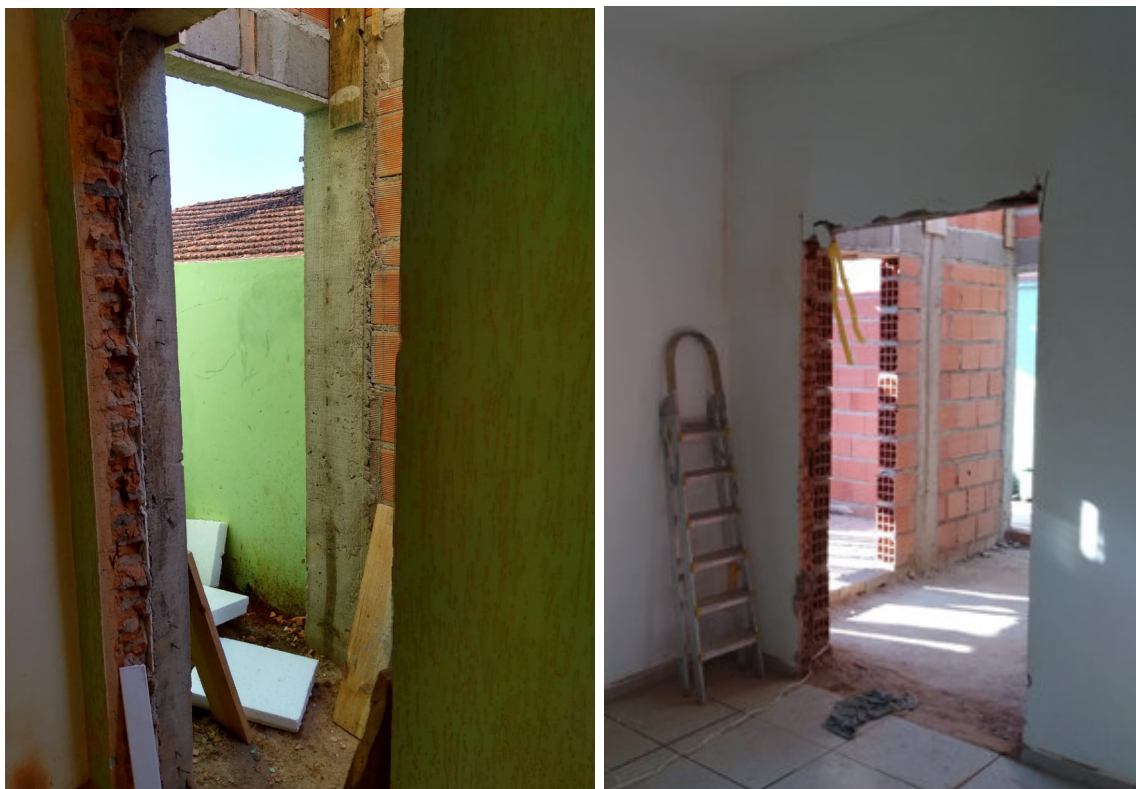
Figuras 1 e 2 – DEMOLIÇÃO (interior da parte já existente)
