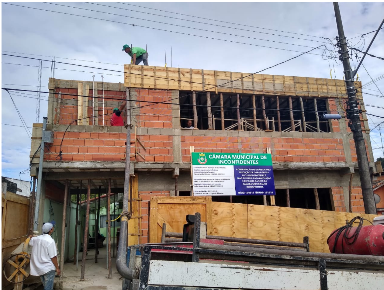
Figuras 1 a 4: ESTRUTURA, ALVENARIA e LAJE
