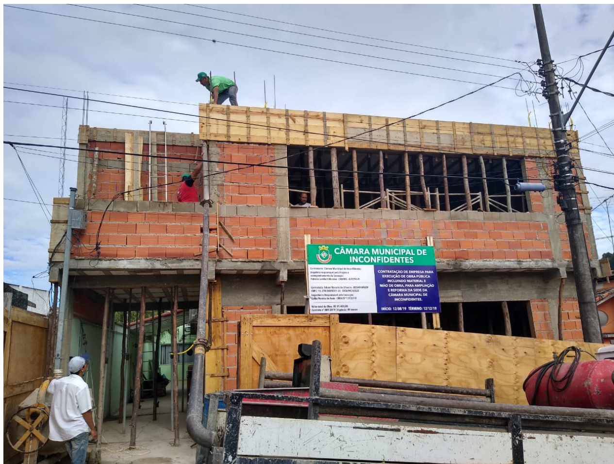
Figuras 1 a 4: Estrutura, Alvenaria e Laje
